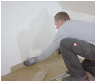
Der Randdämmstreifen RST verhindern Schallbrücken zu aufgehenden Bauteilen.
