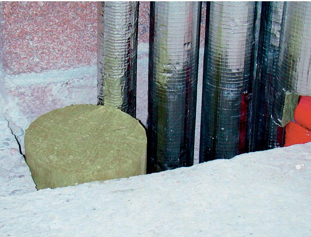
Der Conlit Fire Plug ist ein nichtbrennbares zylindrisches Steinwolle-Formteile und aufgrund seiner hohen Rohdichte besonders druckfest und formbeständig. Er entspricht im Außendurchmesser den gängigen Kernbohrungsmaßen und wird für den feuerfesten Verschluss von Kernbohrungen sowie zur Vorhaltung von Reserveabschottungen eingesetzt.
